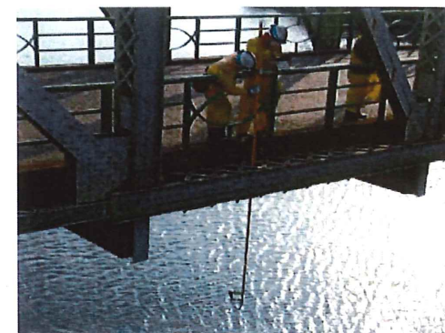
⑤トラス・アーチ橋梁
