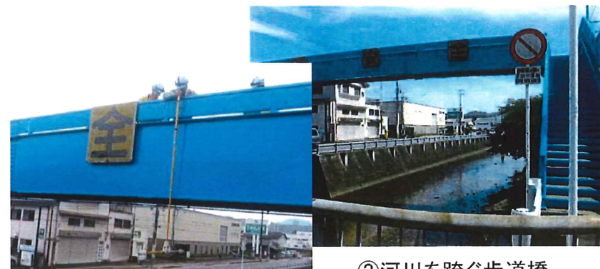
②河川を跨ぐ歩道橋
