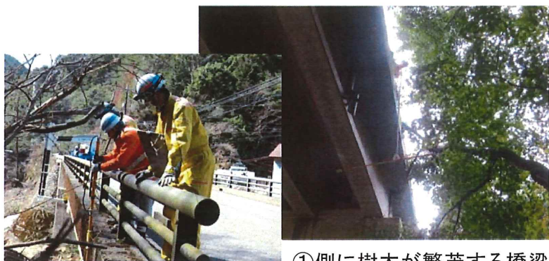
①側に樹木が繁茂する橋梁
